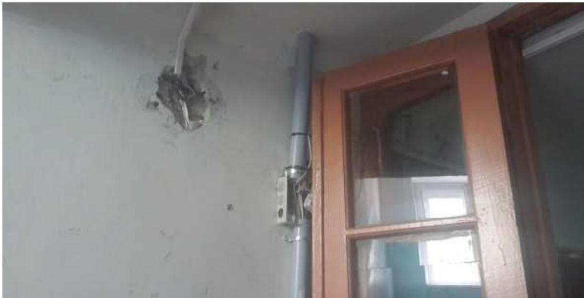
В ночь на 16 июля в коридоре дома в очередной раз произошёл **факт вандализма**: недавно установленное оборудование светильников сорвано на 6-ом этаже, а на 5-ом и 7-ом – висит на одном шурупе.
